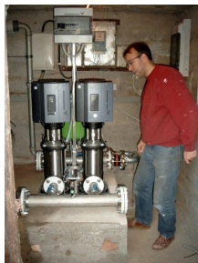
Links: Alte Pumpe, äußerlich rostig durch Kondenswasser Rechts: Neues Pumpen-Duo aus Edelstahl.
