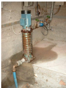
Links: Alte Pumpe, äußerlich rostig durch Kondenswasser Rechts: Neues Pumpen-Duo aus Edelstahl.
